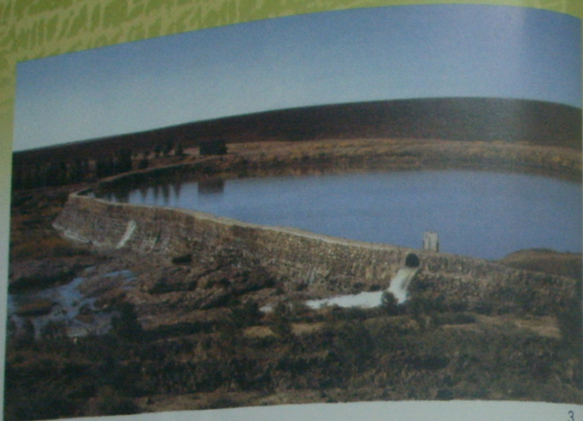
(圖3)蓄水池：為了灌溉和供應水源，西拿基立在尼尼微城外，引入河水蓋了一座蓄水池。這蓄水池和部份的灌溉溝渠一直到今天都還堪使用。
