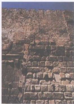
圣殿平台的东边，在两种石砌工程相会合的地方，希律的建筑者们似乎把较大的石块（左边）加在了古旧建筑之上。
