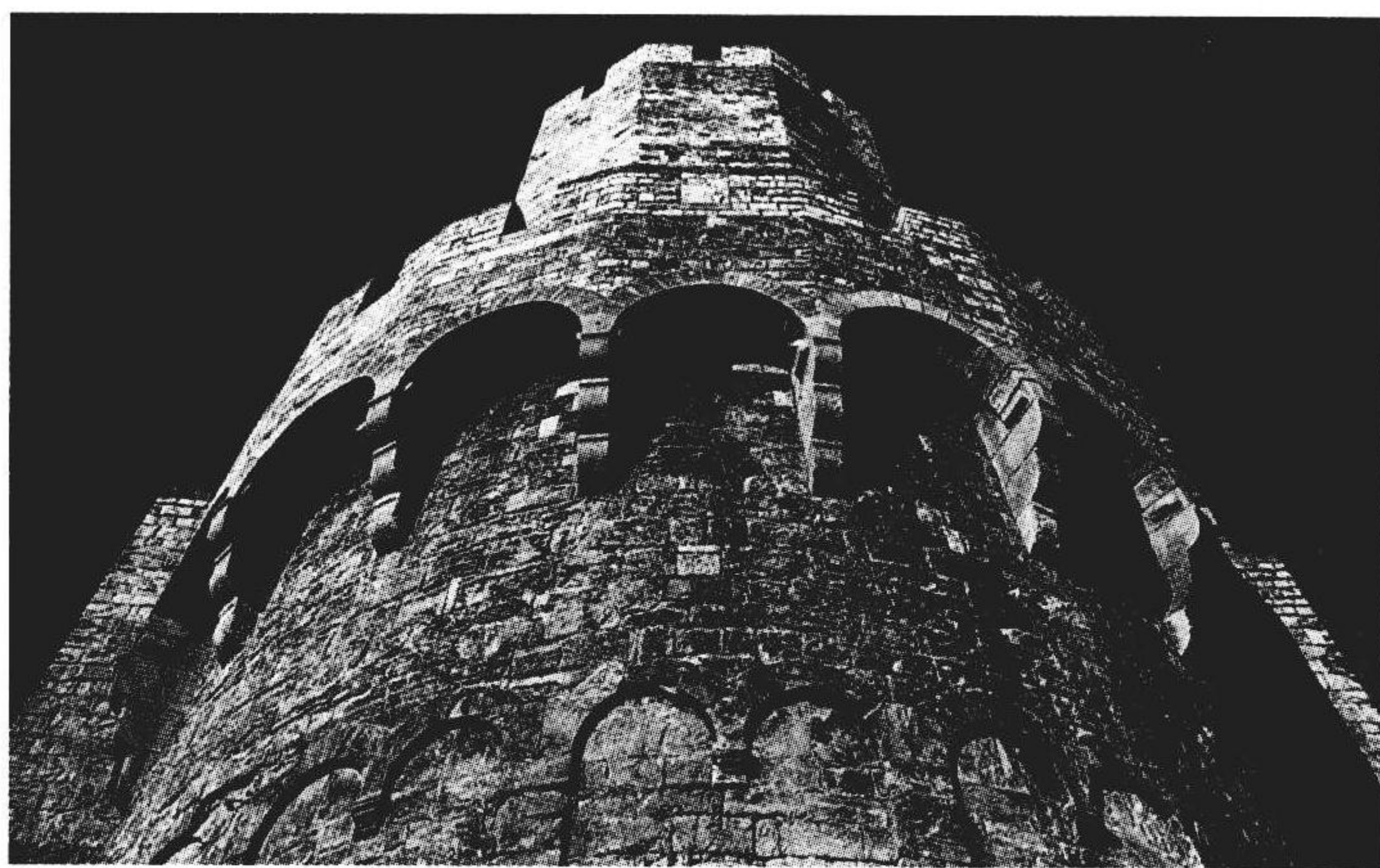
一处战争避难地：圣玛丽斯·德·拉·梅尔（the Saintes-Maries-de-la-Mer）是卡纳尔盖沿岸的一个设防教堂。教堂的半圆形后殿建于1140年至1180年间，顶上面的了望塔建于13世纪。于1394年进行扩建，15世纪增建碟眼。
