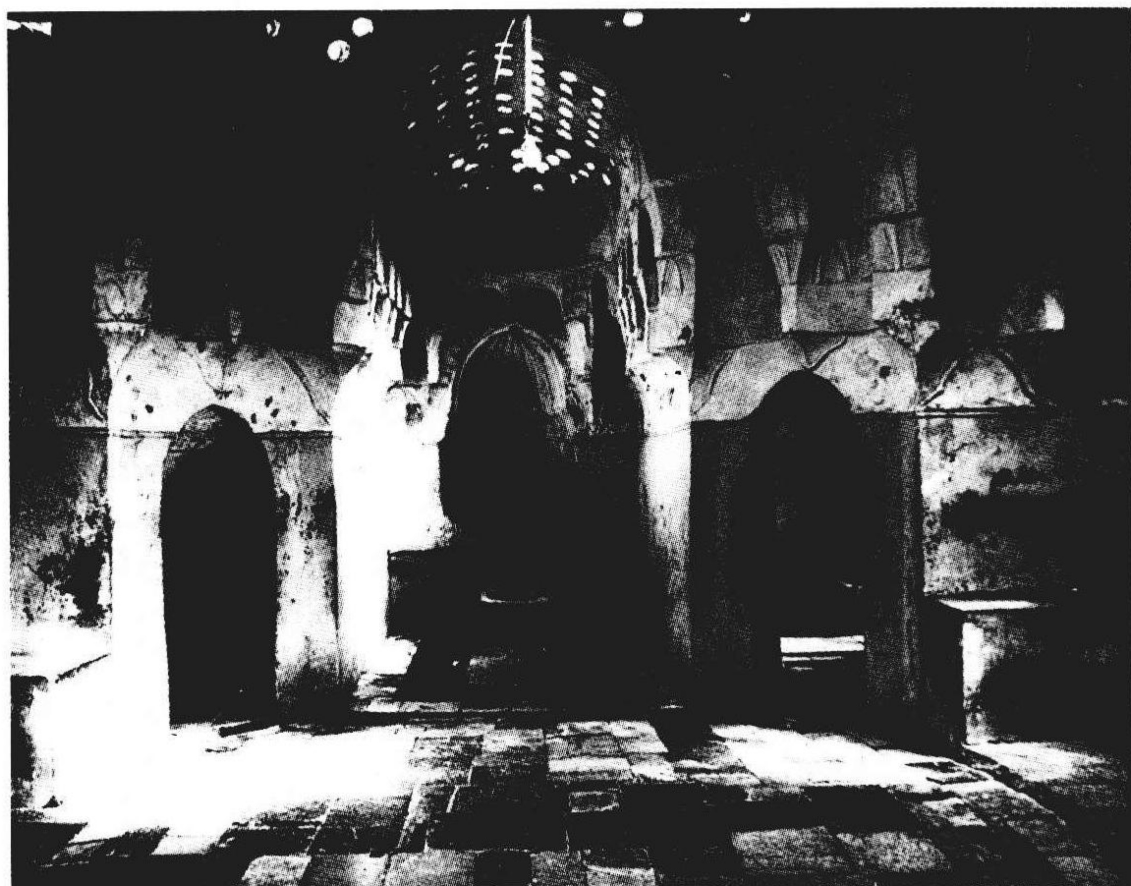
位于大马士革的泰鲁兹澡堂(1444)，仍在使用的最古老的澡堂之一。供热系统供应连在一起的、热量不断增加的三间房，最后且最热的房间是侧面用于沐浴的小房间，中间是水渗出的地方。
